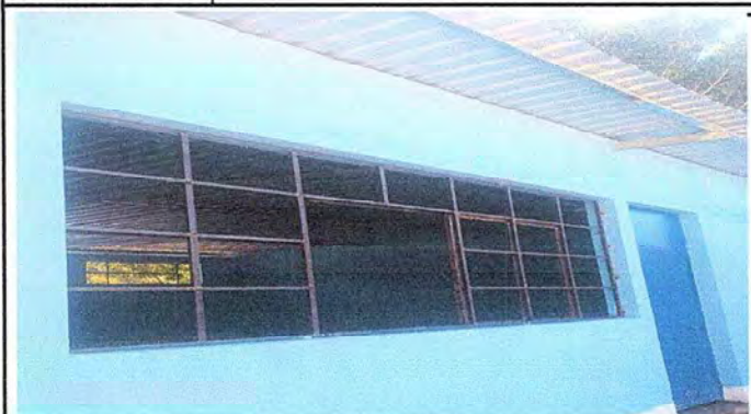
Foto 1: MEJORAMIENTO DE PAREDES DE MADERA A BLOCK
