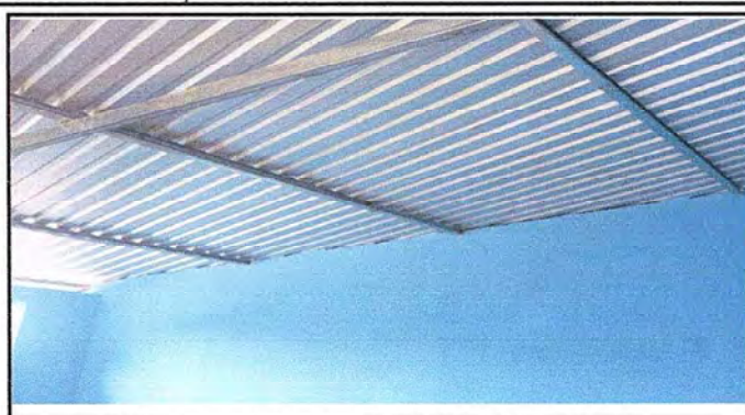
Foto 2: SUSTITUCION ESTRUCTURA DE MADERA POR METAL
