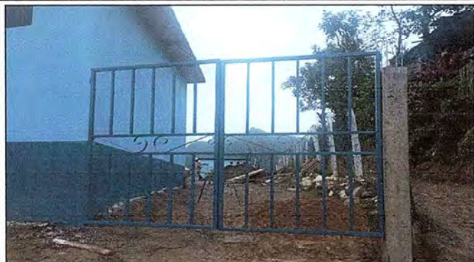
Foto 7: MEJORAMIENTO DE PORTON DE MADERA Y MALLA POR METAL
