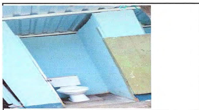
Foto 4: MEJORAMIENTO DE SANITARIOS
