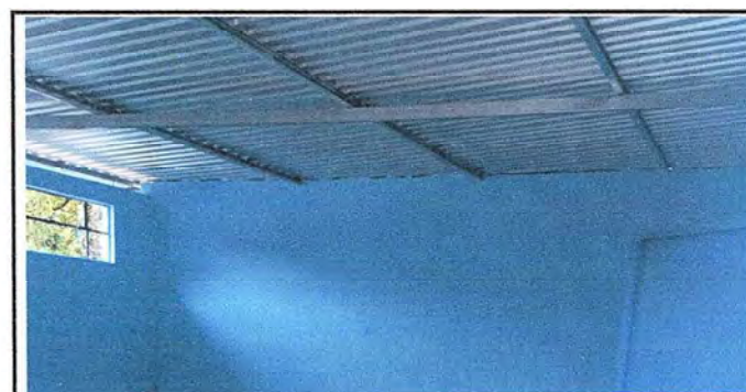
Foto 6: APLICACIÓN DE PINTURA EN PAREDES
