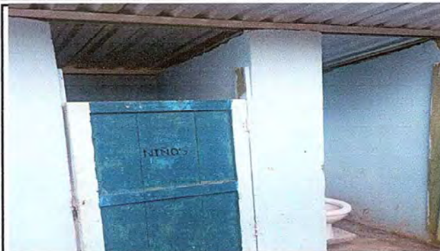
Foto 8: MEJORAMIENTO TECHADO DE SANITARIOS
